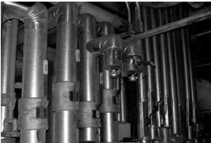
用于主蒸汽疏水的 MOGAS RSVP 阀门壁厚, 性能要优于原始的截止阀。生产中暴露在 950°F, 1875 psi (510°C, 129 bar) 的环境下, 阀门的可靠运作和密封是极为重要的。
