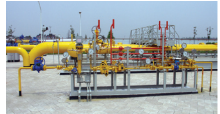
Dans cette station de compression située à Pékin, en Chine, ces vannes FlexStream contrôlent avec précision la réduction de la pression afin de protéger les réseaux locaux de distribution de gaz.
