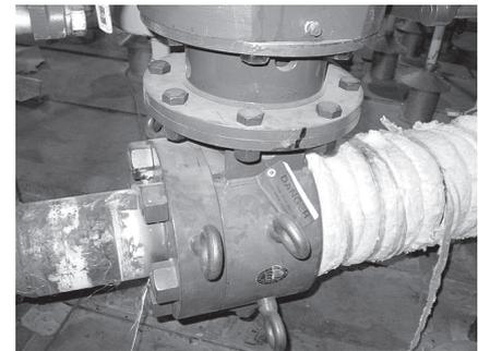
La válvula de la Serie C fue elegida para el sistema de purga de caldera por nuestro cliente debido a la ágil operación disponible con la rápida rotación de cuarto de vuelta y el apagado total. Estas fotografías fueron tomadas durante una parada de mantenimiento rutinaria una vez retirada parte del aislamiento.
